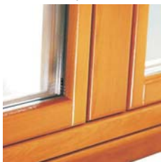
Εξωτερικά το φύλλο και η κάσα του υαλοστασίου είναι πρόσωπο
