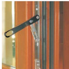
Σπανιολέτα ανοίγματος του δεύτερου φύλλου.
